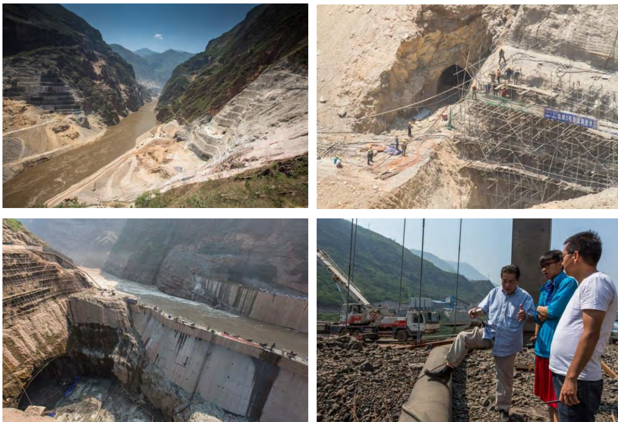
图 15 乌东德、白鹤滩水电站施工现场
