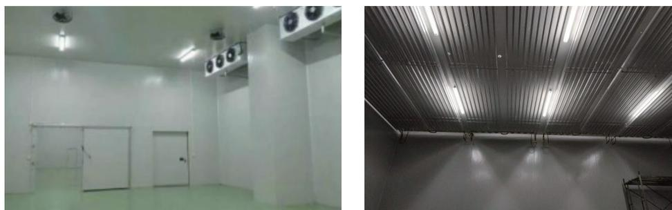
图 4-3 冷库风制冷和排管制冷方式
